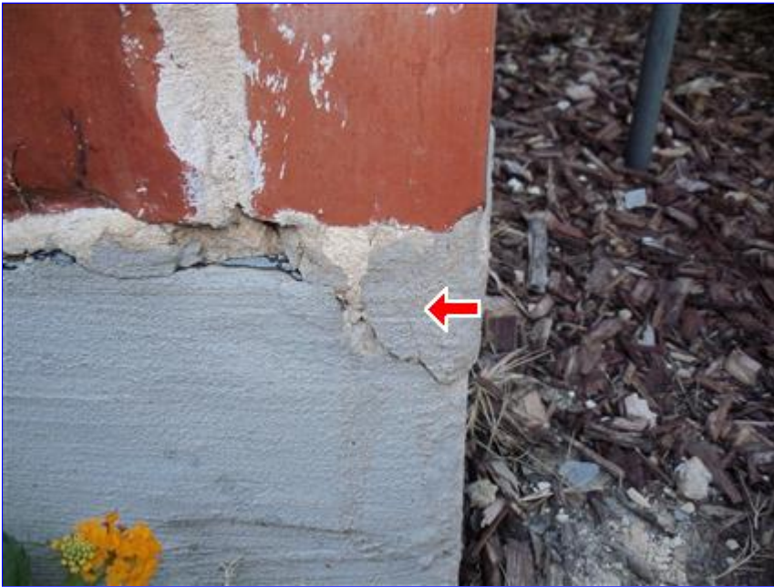
A. Picture 2 NE Corner
