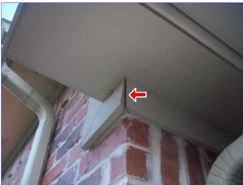
E. Picture 3 SE Corner
